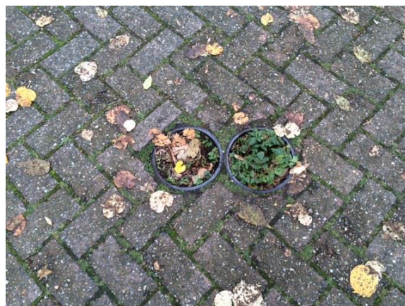
Vulpunten zichtbaar in klinkerbestrating
